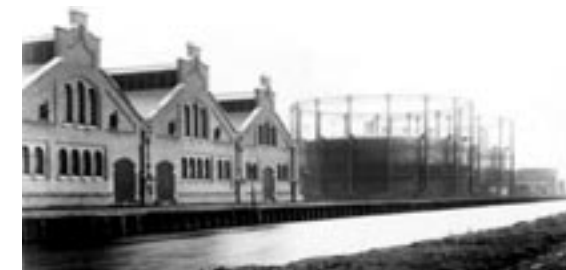
Zuiveringsgebouw en gashouder
